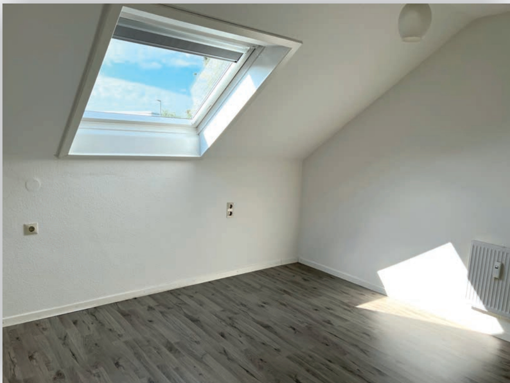
Stauraum im Drenpel
